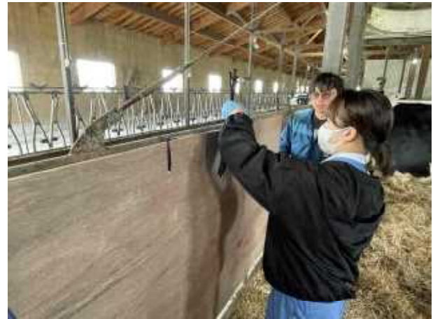
農業者と分娩房の改修作業 (D農場)
