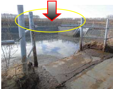
写真6 スラリストアの スラリー落とし口
