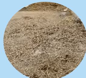
サイロの汚れや崩壊
