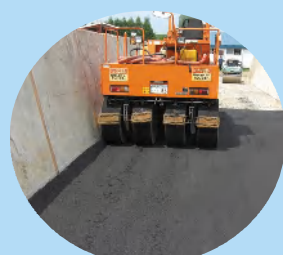
アスファルトで床面を補修
