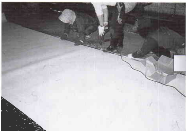
カバーシートを牛床後部に敷き板で押さえアンカーボルトで固定
