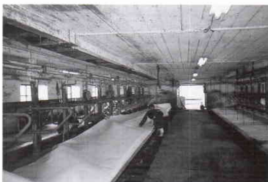
カバーシートを折り返して、牛床後部から 3cm位引っ張ります
