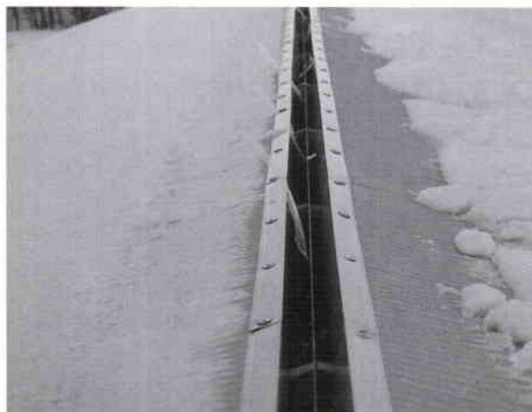
棟開放（オープンリッジ）は連続的に風が抜けています。（白いリボンに注目）
