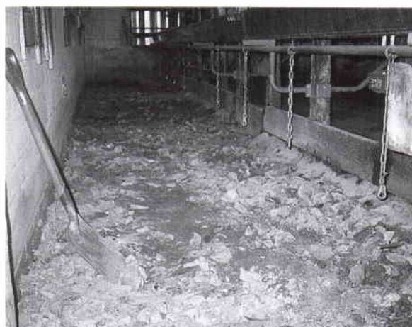
飼槽と通路を壊したところです。
