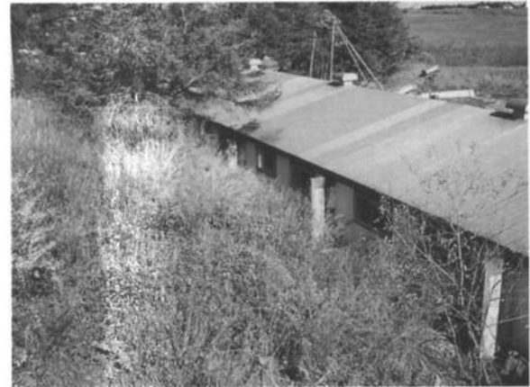
写真1 牛舎近くまで崖が迫っているため風の通りが悪い。
