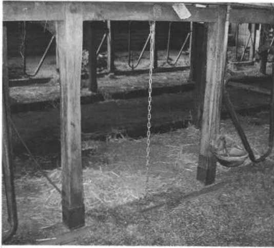
写真17 上下支点方式による繋留
