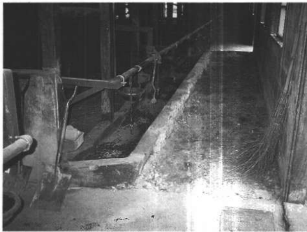
写真19 コンクリートを切断し撤去
