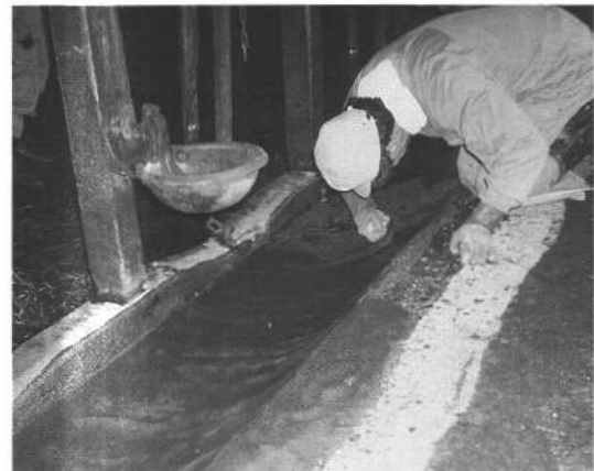
写真17 レジコンの施工
