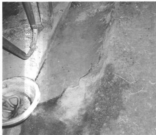
写真14 FRPが剥げてしまった飼槽
