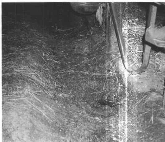
写真13 モルタルの表面が摩耗し残飼が腐敗している飼槽
