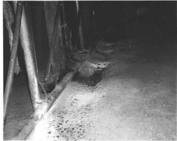
写真11 石の出してきた飼槽
