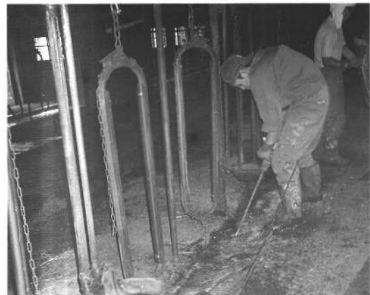
写真16 既存飼槽表面の処理（撤去）
