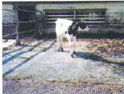
クリンブ金網だけを用いた方法。地面に置き、上から火山灰で網の目をふさぐ。時間の経過とともに地面と馴染む。周囲のそり上がり防止のために線形4mm、メッシュ30または17mmが適切なようで、北農試農地農業施設研究室で検討中。(写真：同研究室より)
