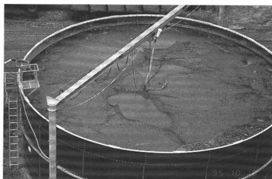
写真24 スラリートタンク
