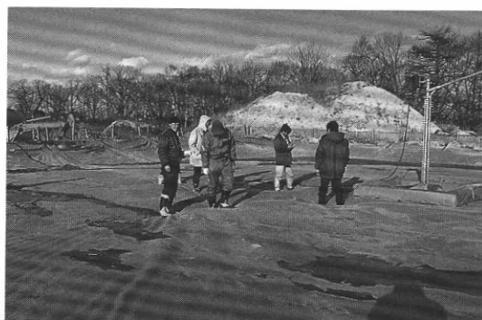
写真25 スラリーバック
