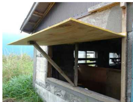
写真30 窓を改造し開口部を拡大
