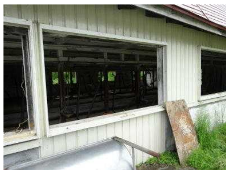
写真27 窓を外して開口部拡大
