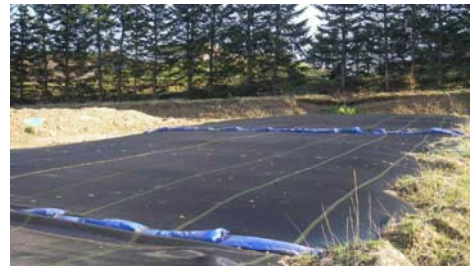
写真42 耐久性の高い被覆材の使用例
