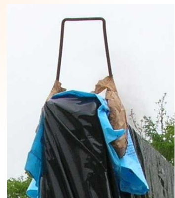
写真46 シートを抑える金具にブルーシートを挟んだ事例
