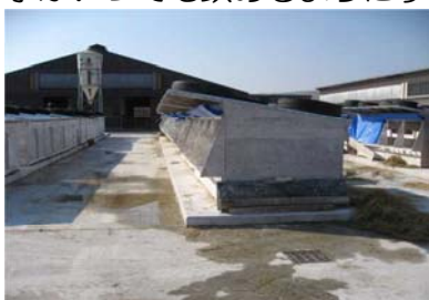
写真16 屋根を延長して日陰を作った事例
