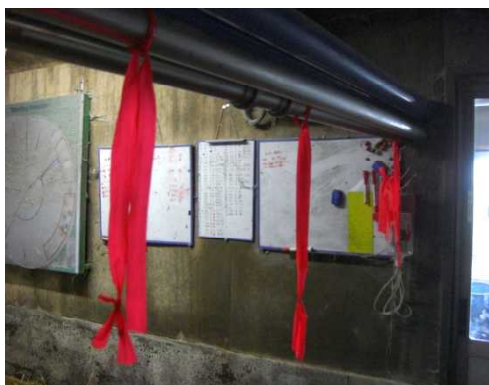
写真1 低い配管にカラーテープで目印をつけて通行時の頭上注意
