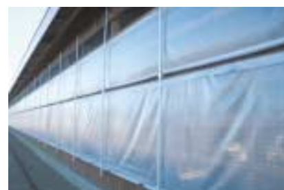
写真26 上部を少しあけて換気量を調整
