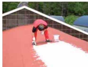
写真7 屋根を白色に塗装している事例
