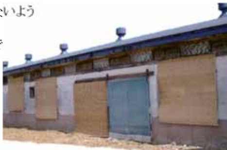
写真3 すだれを利用した西日対策
