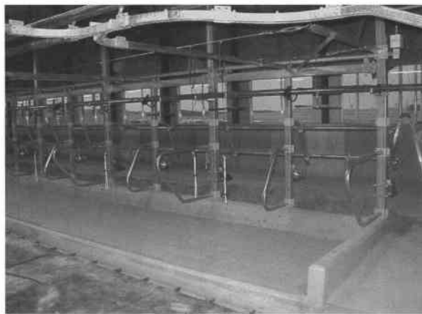
写真3 ゴムチップマットレスの設置事例
