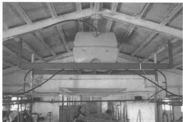
写真15 貯留タンク+バイパス管の設置
