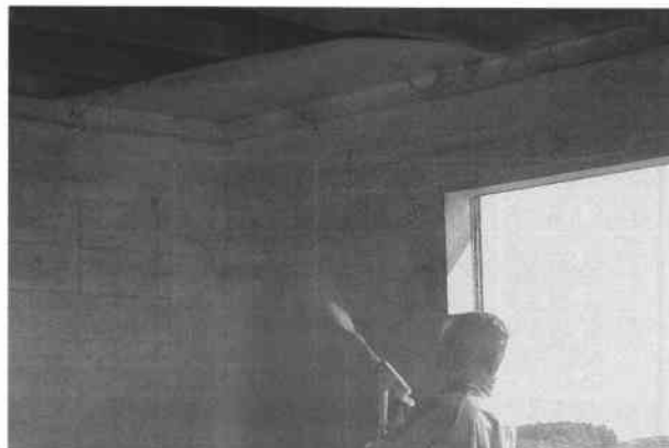
写真17 石灰乳塗布の様子
