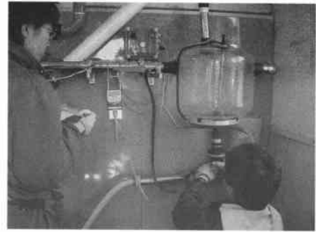
写真15 システム点検
