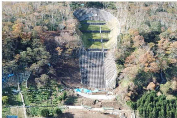
●富塚地先林地荒廃防止施設災害復旧工事（羅臼町海岸町）
