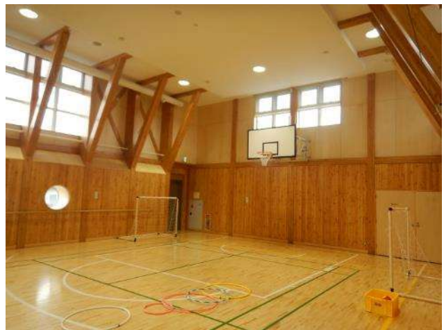
●道産カラマツ材を使用した公共施設(中標津町児童センター「みらいる」)
