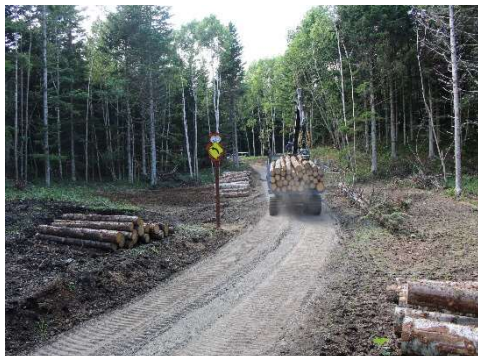
●路網整備後の森林整備状況(別海町)
