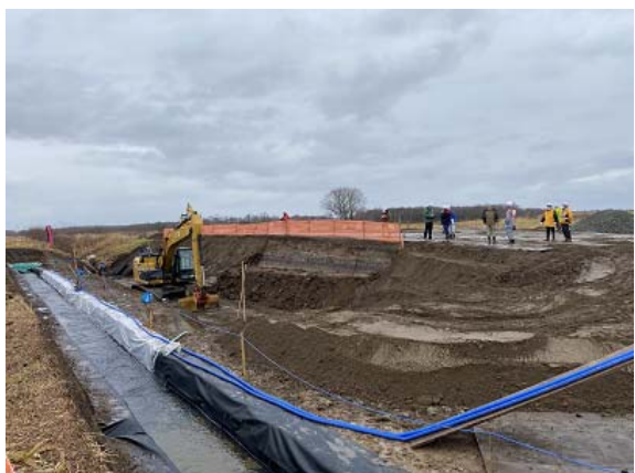
函渠工施工のためのバックホウ床掘作業
