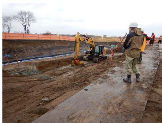
作業計画書、立入の分離措置などを点検
