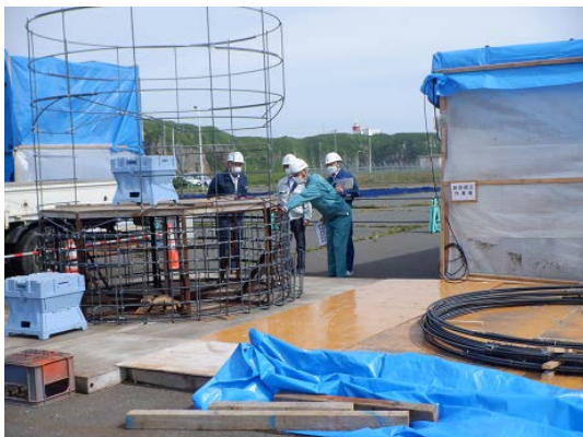
鉄筋の保管状況等を点検 (水産課_所管@魚礁製作設置工事)
