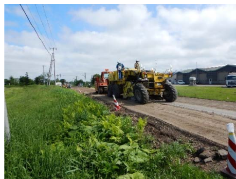
フォームドスタビライザによる施工状況 2
