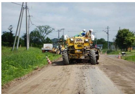
フォームドスタビライザによる施工状況 1
