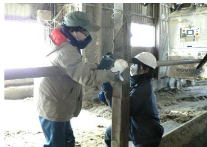
写真3 マンパワーで低コスト飼槽ネックレール改修
