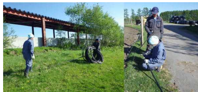
放牧地に新設する水槽の水配管施工
