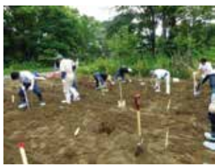
縦孔暗渠の施工
