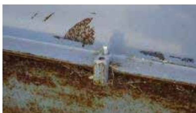
写真2 鉄板同士の接続
