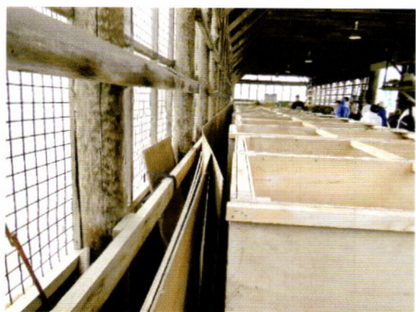
写真10 壁とペンの間にコンパネを設置した寒さ対策
