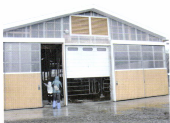
写真14 換気ファンを設置し積極的に換気
