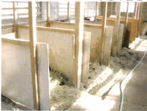
事例1 旧つなぎ牛舎をペンに改造①
