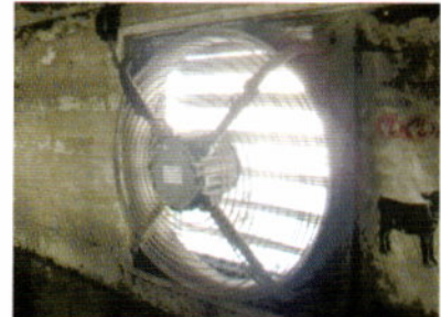
写真19 旧つなぎ牛舎窓に換気扇を設置した換気対策
