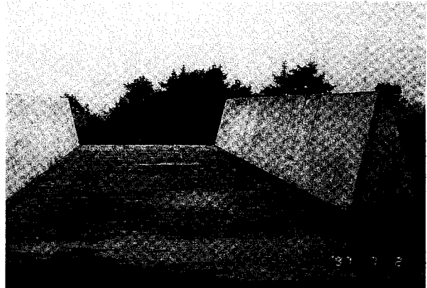
写真2 きれいに清掃され詰込みを待つバンカーサイロ
