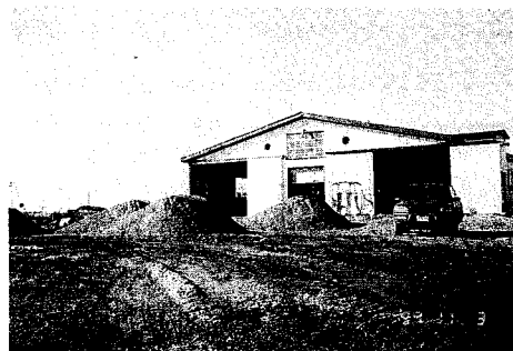
写真5 牛の出入口（通路） 砂や火山灰を敷き、畜舎からの牛の出口、通路がぬかるみにならないような工夫
