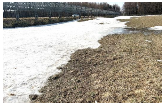
写真1 雪が残りやすく、凍結が抜けにくい防風柵周辺（R5年4月10日）
