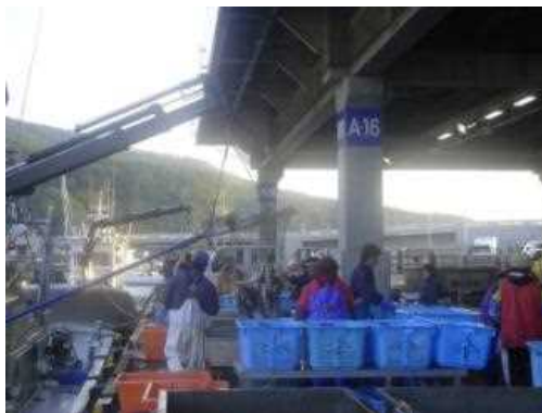
羅臼漁港 人工地盤
