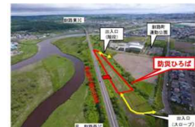
釧路町 緊急広場整備
