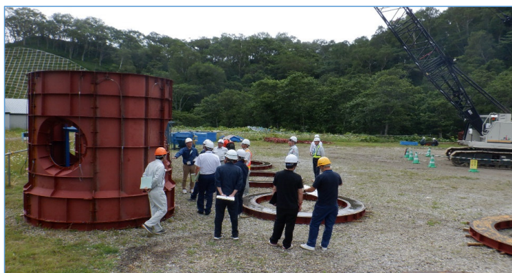
魚礁ブロックの制作状況等を点検 （水産課_所管@魚礁製作設置工事）
