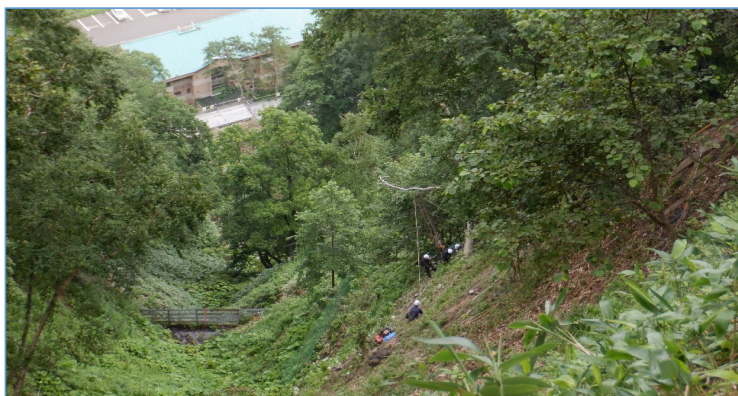
高所作業時の保安状況を確認 （林務課_所管@フリーフレーム工事）
