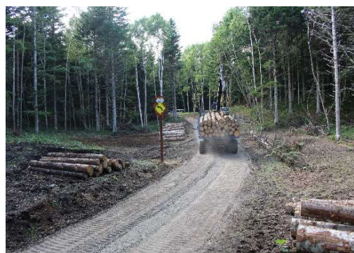
●路網整備後の森林整備状況(別海町)
