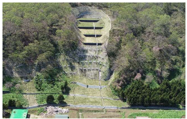
●富塚地先林地荒廃防止施設災害復旧工事（羅臼町海岸町）
