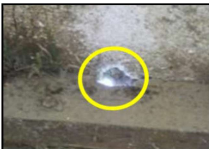
壁等の破損修繕
