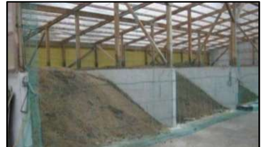
堆肥舎のネット設置
