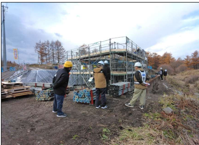
橋台の鉄筋型枠作業での安全対策を点検
