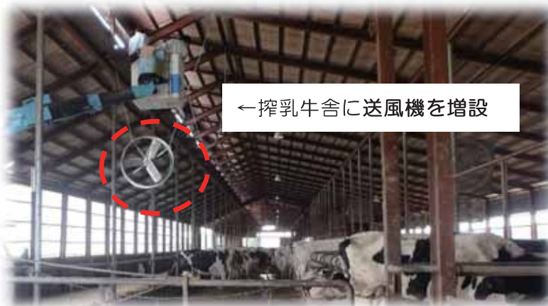
←ホールディング エリア(アブレスト パーラー)に送風機 を増設
