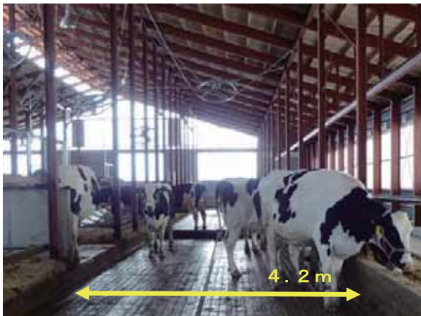
写真1 飼槽前通路の幅を広くとる エサを食べている牛の後ろを2頭がすれ 違える広さを確保しています。
