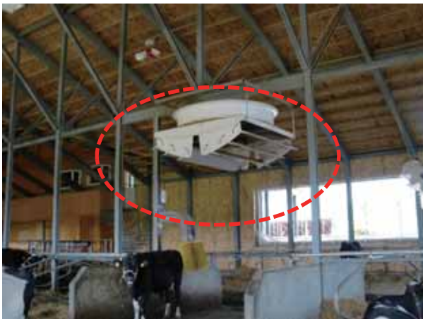
写真3 大型換気扇の利用 換気扇を常に動かし、空気のよどみを解消 して、乾物摂取量の向上を図っています。
