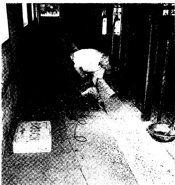
写真8 施工中（削岩機によるタイル撤去）
