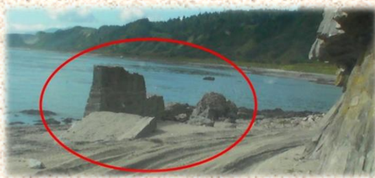
赤岩に残るコンクリート製の防波堤跡 (2011年9月撮影)
