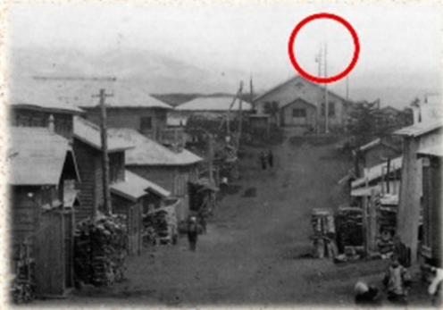
紗那警察署の隣りに建物が出来ており、上の写真よりは新しいもの。櫓にはやはり半鐘が吊されている
