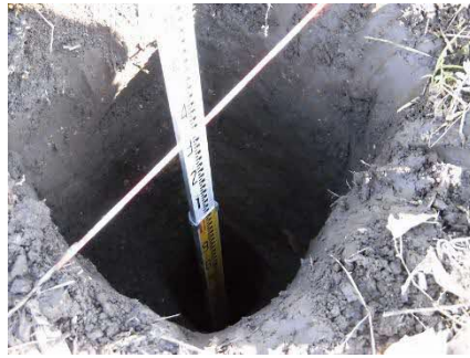
写真1 ①明きょと②カットソイラーの施工 写真2 ③縦孔暗きょの施工
