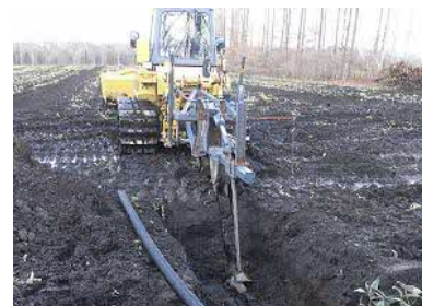
写真4 カッティングドレーン施工
