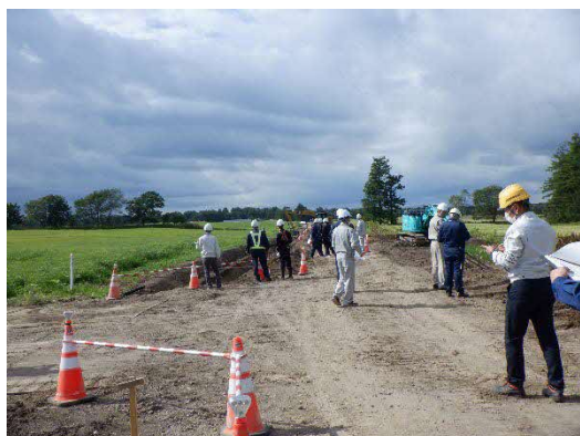
転落防止のための防護柵や標識を点検 (農村振興課_所管@農道工事)
