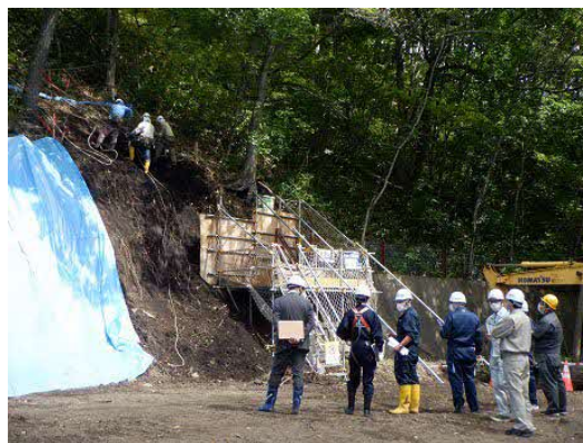
作業員の安全や機械の保安状態を確認 (林務課_所管@土留工老朽化工事)
