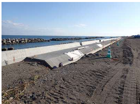
カラーコーン等による作業区域の分離措置
