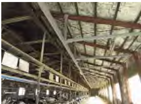
写真3 給餌機が移動するレール
