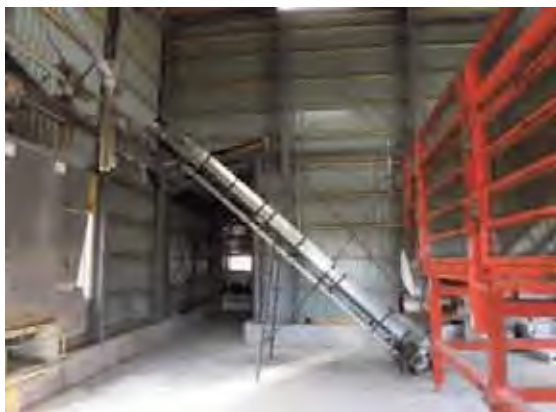
写真1 ダンプボックスからコンベアでTMRを投入
