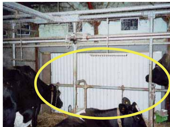
写真7 作業通路にアコーディオンカーテンを設置して作業性と密閉を両立
