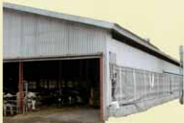
開口部が少ないため、換気効率が良くない
