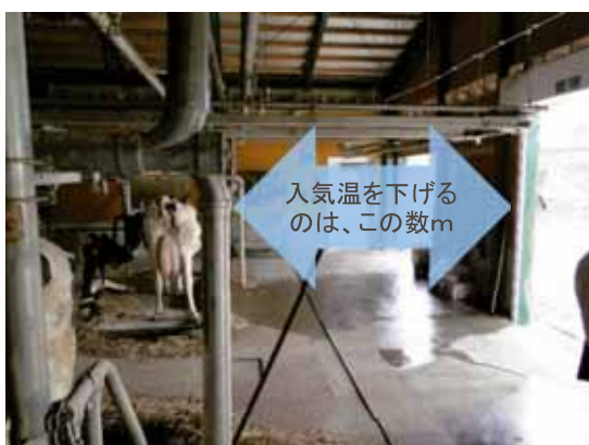
写真11 入気口上部に設けたミスト配管
