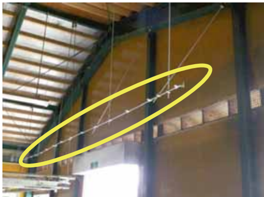
写真11 入気口上部に設けたミスト配管
