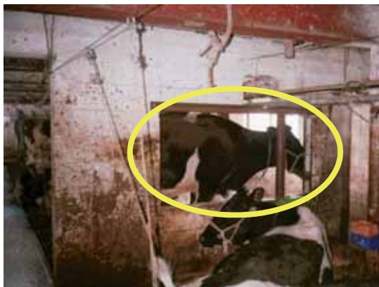
写真6 風が通るように壁を除去
