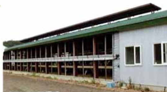
写真2 開口部を最大にして換気量確保
