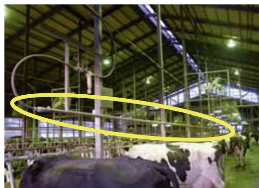
写真14 ソーカーの設置事例
