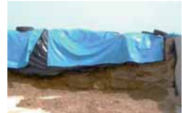
写真3 取り出しを北から行い直射日光を避ける。日光が当たる場合はシートを垂らす
