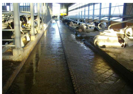
写真3 十分な通路幅（ストール側）
