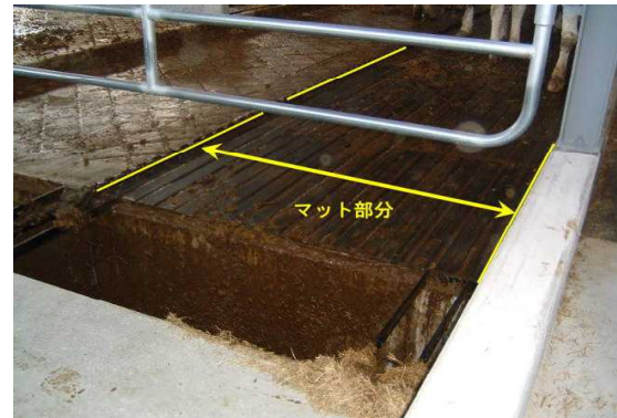
写真13 部分的にマットを設置
