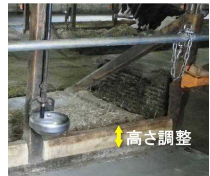
写真9 高くした飼槽隔壁
